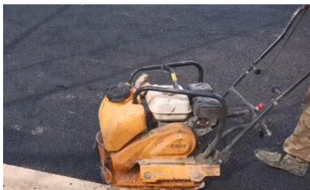
图 7-5-3 人工夯配合边沿压实
