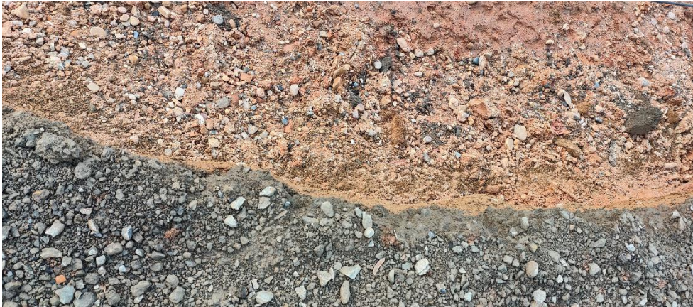
图 9.2 原路基挖除图
