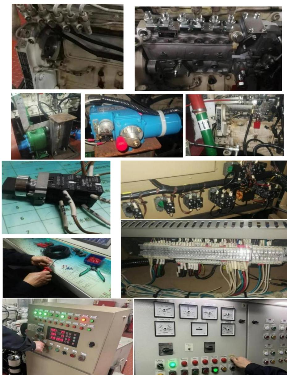
实施目标检查：2022年9月28日所有安装施工完毕后，小组成员一起对各部件联接情况进行检查和确认，支架牢固；应急手动、通电机旁远控操作可靠和同步；低速，高速限位动作及时有效；安保测试响应及时，发电机组负载试验均满足规范要求。组装、测试、检验成功。
