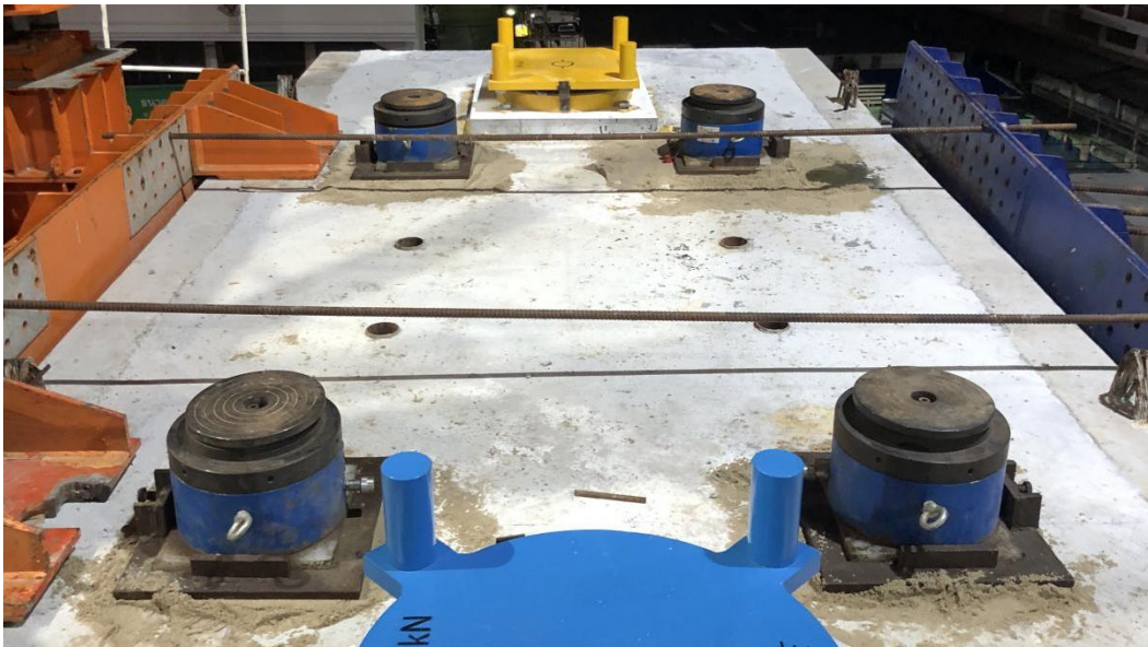
图 9-4 墩顶节段箱梁安装调节定位装置安装及位置分布
