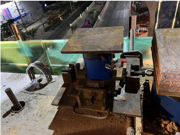
图 9-1 墩顶节段箱梁安装调节定位装置
