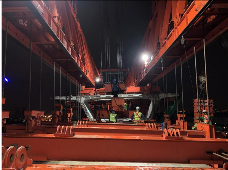
图 7-10 节段箱梁吊放
